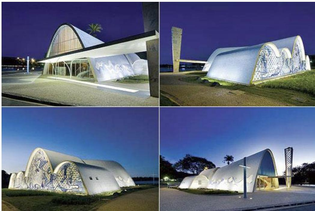
Nella Cappella di San Francesco la sensualità delle forme diviene l'elemento dominante: scomparsa l'ossatura verticale, cinque volte paraboliche autoportanti di diverse altezze e curvature generano una voluttuosa intersezione e una fusione di volumi che sembrano riprodurre i paesaggi naturali del Brasile, e che
