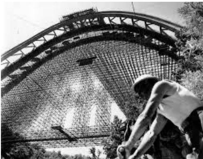
Domus: viadotto dell'Autostrada del Sole in costruzione
