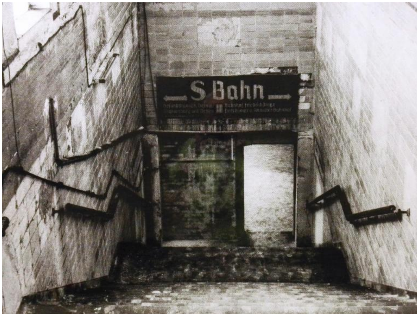
L'accesso murato alla stazione S-Bahn di Nordbahnhof.
